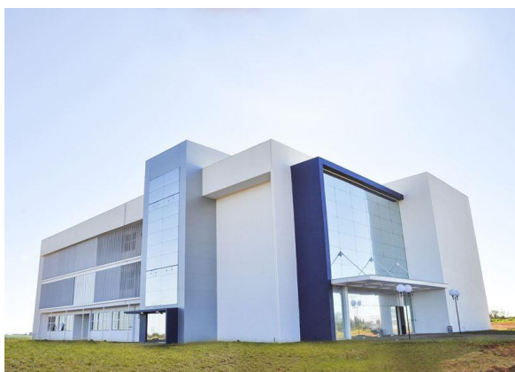
Edifício V2 – nova FEAR.
