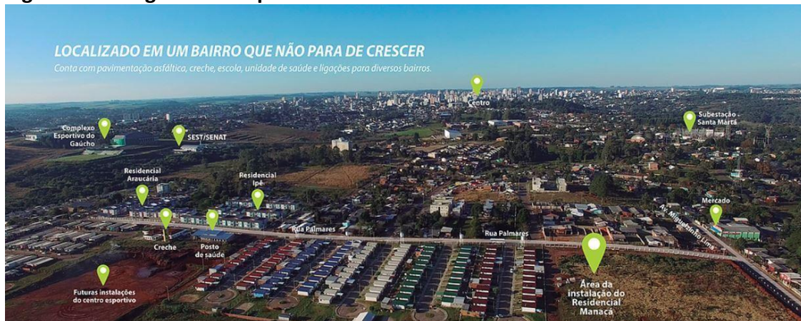
Figura 1: Vista geral do empreendimento Jardins Nativos
