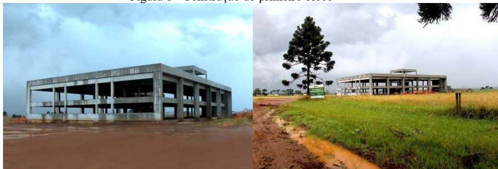
Figura 8 - Construção do primeiro bloco
