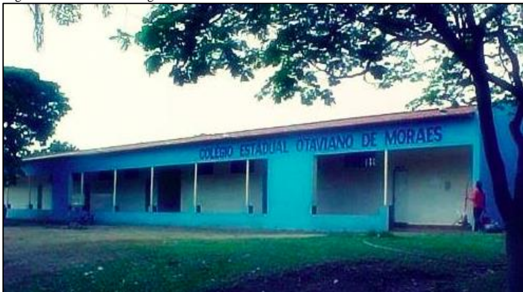
Figura 2 - Fachada do Colégio
