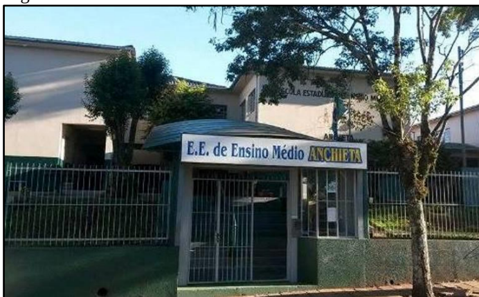
Figura 5 - Fachada da escola
