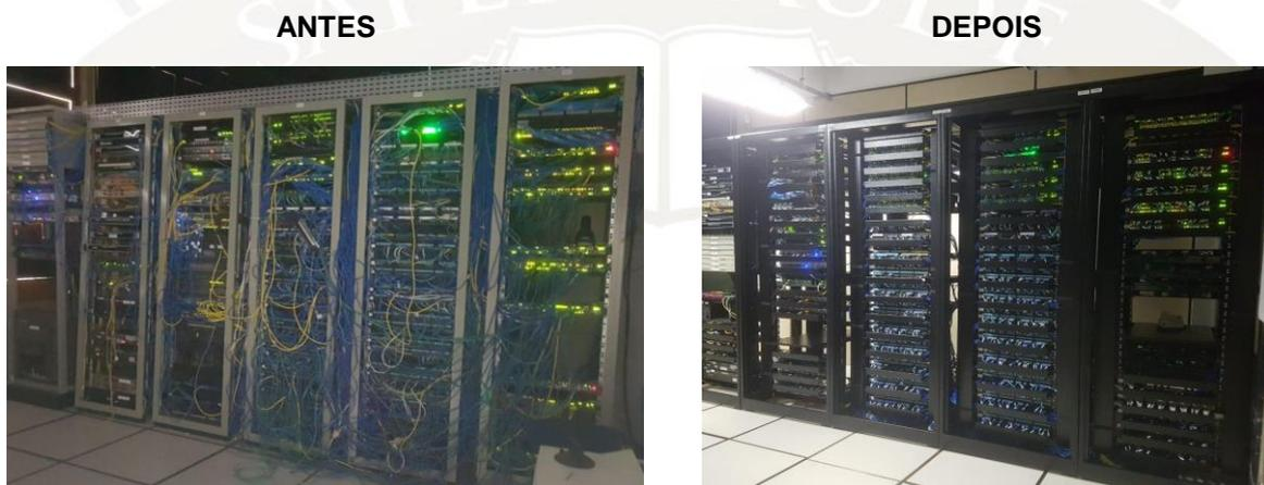
Figura 3: Racks Data Center comparação antes x depois da reestruturação de cabeamento
